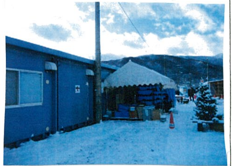
下屋が完成までの仮女子棟入口。硬ゴミ箱 AM7:20 10cm、-6℃
