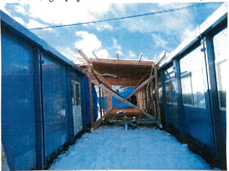
女子宿舎棟と事務棟の間 柱と屋根の部 12/17
