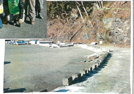
きれいに整備・清掃した仮宿漁港の岸壁
