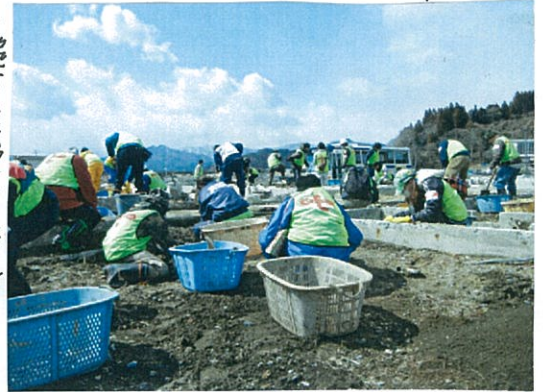
大槌町被災地区瓦礫撤去の様子
