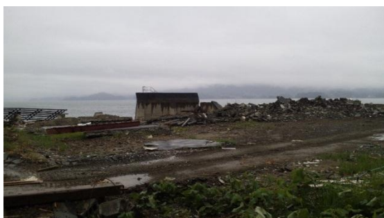
陸前高田・決壊した堤防
