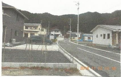
造成地に新築された家々
